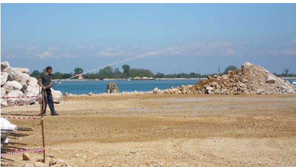
15. Bagnatura del terreno all'interno di una area di cantiere per limitare la risospensione di polveri a causa del passaggio di veicoli pesanti.
