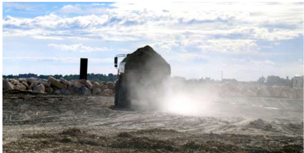
12. Esempio di rilascio di polveri dovuto al transito di mezzi pesanti all'interno del cantiere di Punta Sabbioni.
